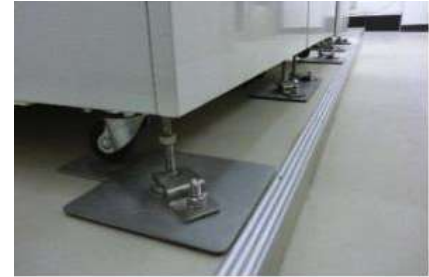
耐震用ジェルで床面固定
